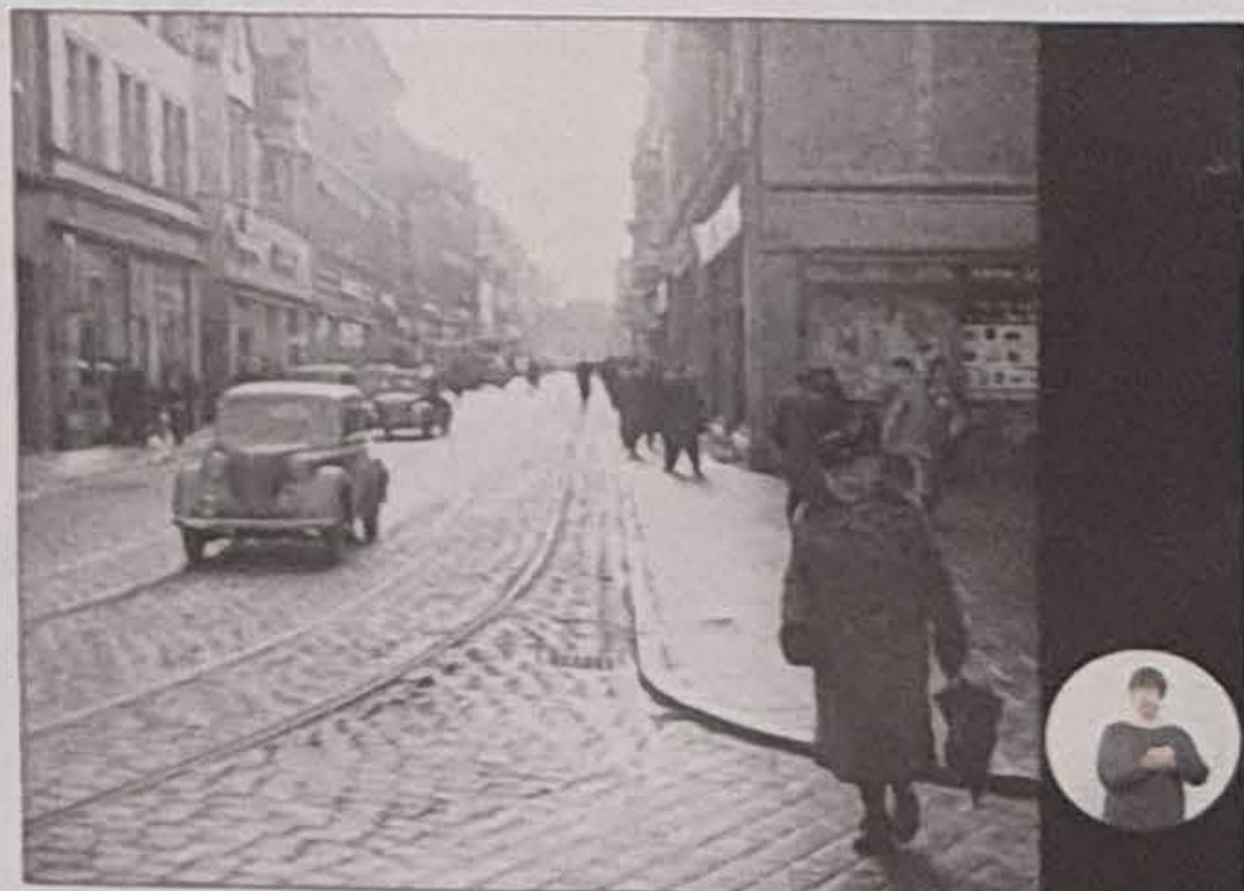
Die Bahnhofstraße mit Blick zum Jahnplatz 1953. Das Bild stammt aus dem Kurzfilm „An einem Faden“, hergestellt von „Film in Wissenschaft und Technik“. Foto: Tri-Ergon
